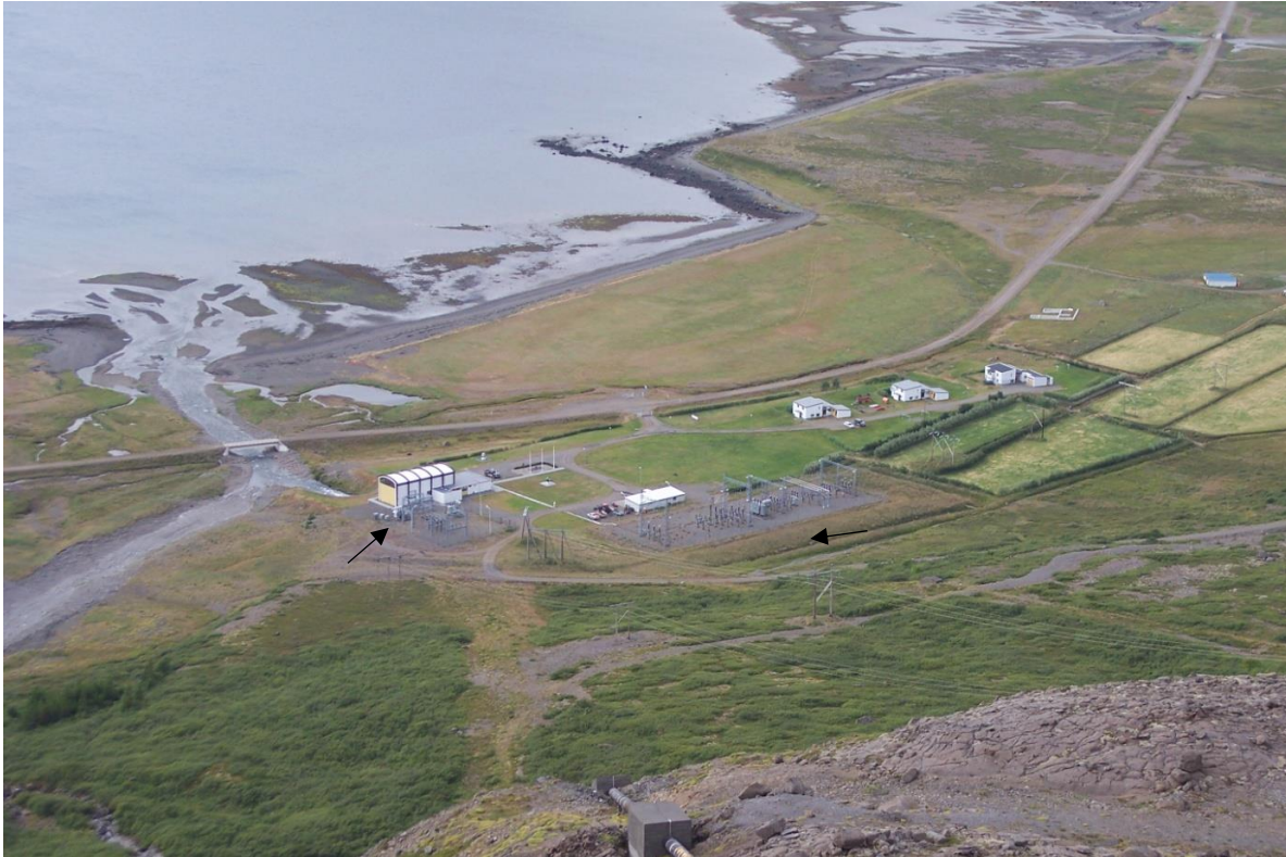
Mynd 3-5 Séð frá fjallsbrún við Mjólkurárfossa niður í Borgarfjörð. Stöðvarhús Mjólkár I og II er til vinstri. Á myndinni sjást tengivirki og örvarnar sýna fyrirhugaða staðsetningu þeirra.
