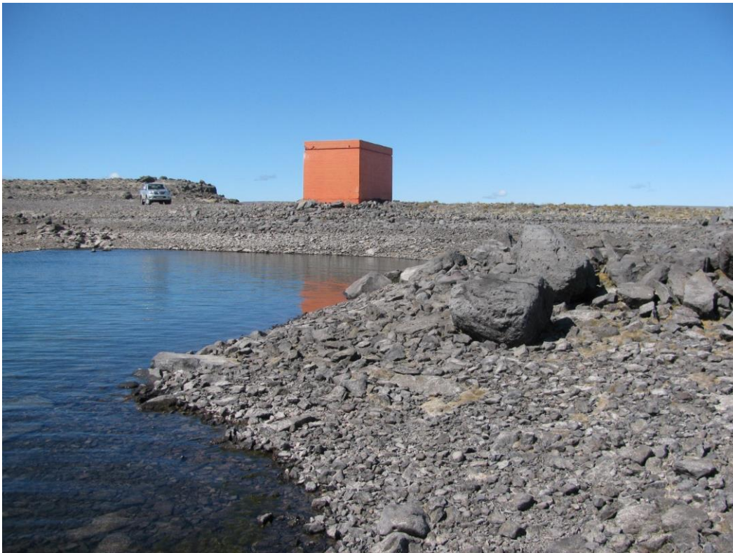
Mynd 8-5 Tangavatsnstífla. Fyrirhuguð stífla norðaustan við vatn í 626 m hæð verður svipuð ásýndar en hærri og lengri.
